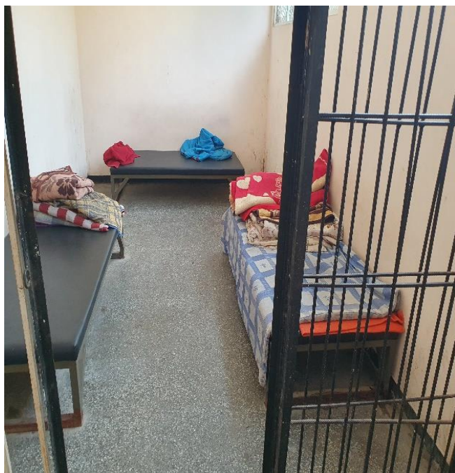
Помещение за настаняване
